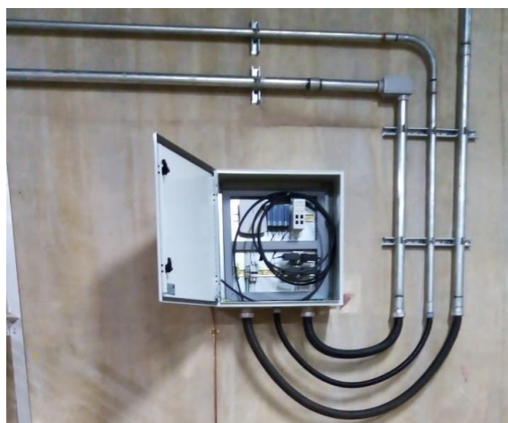
Figura 3 - Modelo de CFAP - Caixa de Fixação de Access Point
