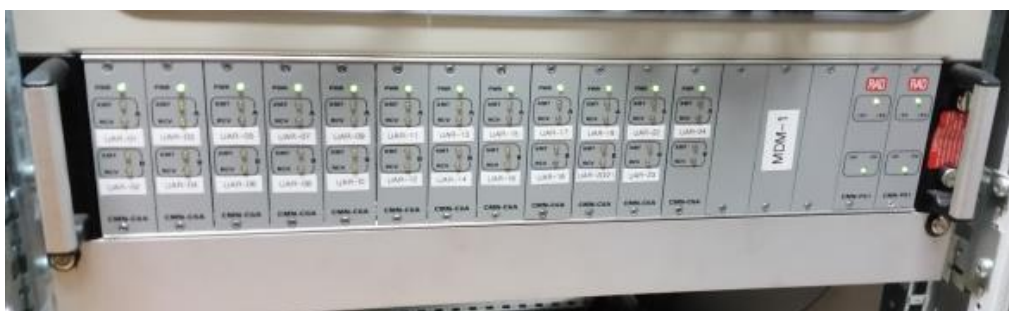
Figura 12 – Rack com os modems RS232 da CDA.
